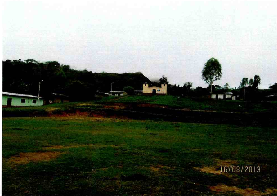
VIVIENDAS AGRUPADAS DEL SECTOR OESTE DEL C.P. EL HIGUERON
