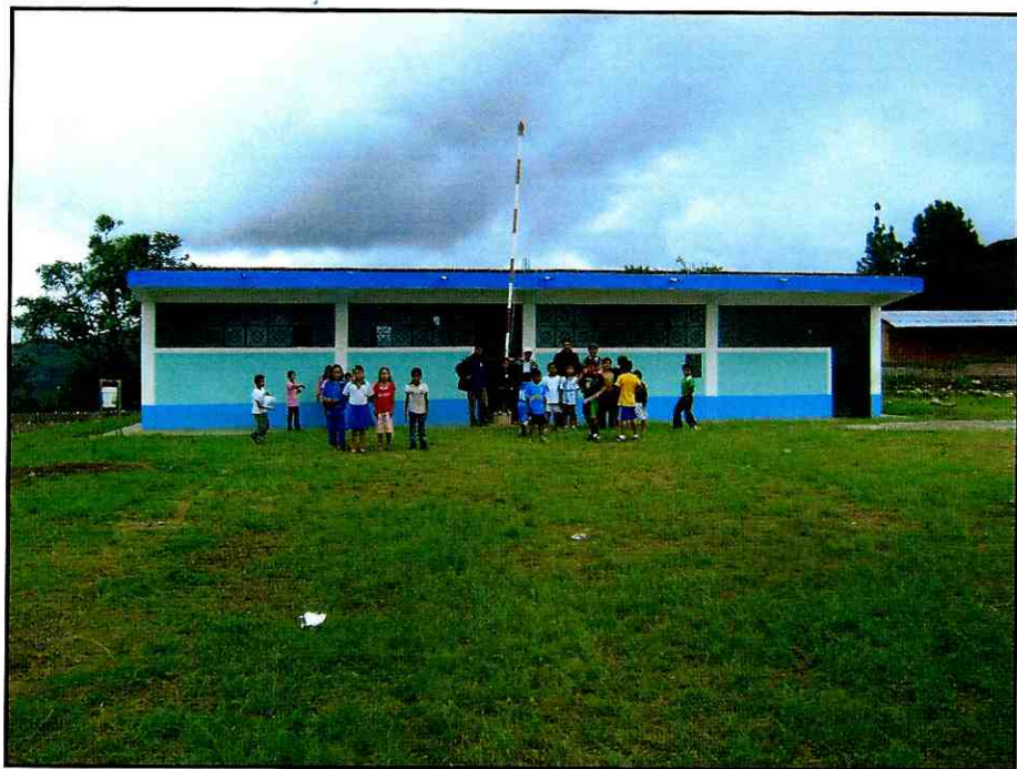
AULAS I.E.PRIMARIA N° 17668 – LA PALMA CONSTRUIDAS POR LA M.D. CHIRINOS
