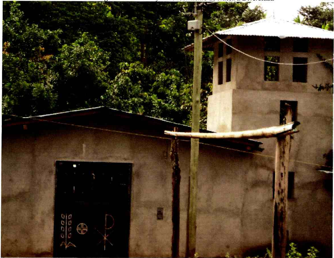
CASA COMUNAL DE USO MULTIPLE C.P. SAN FRANCISCO
